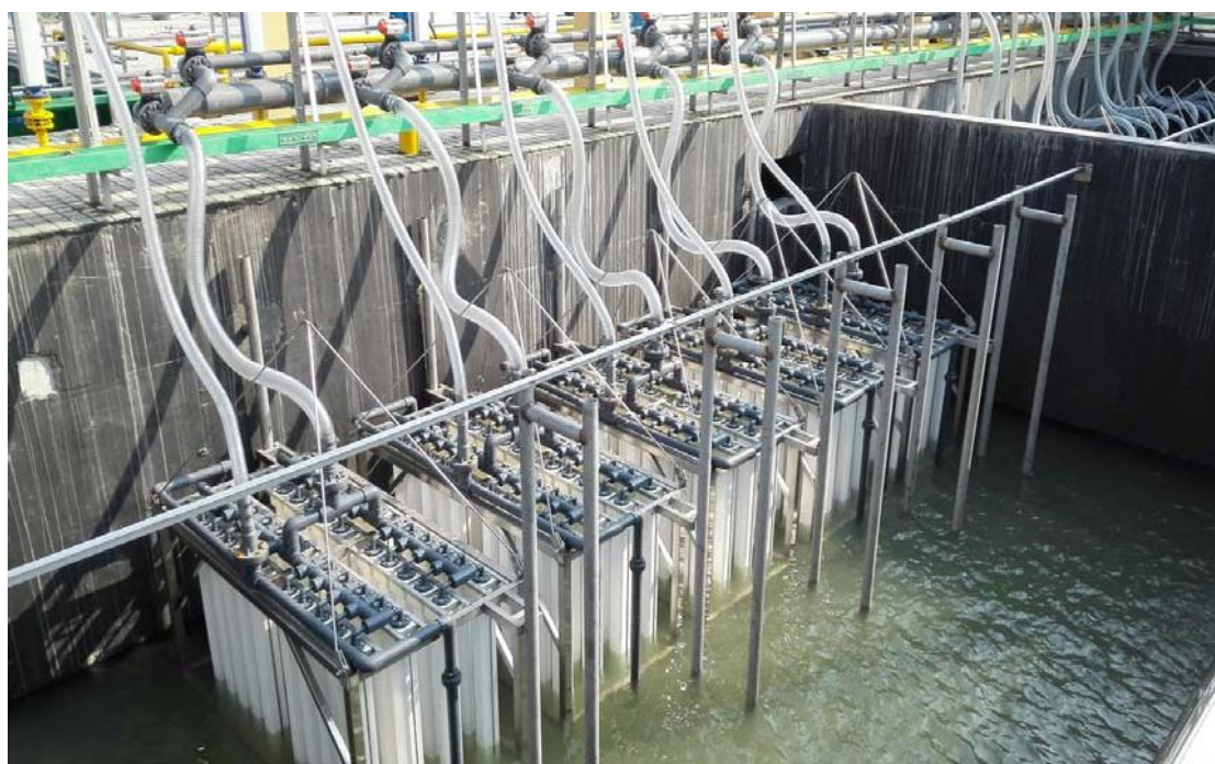
图7.2-10 HMCRC 现场安装图
